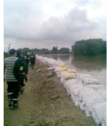
Wały wzmocnione workami z piaskiem.
