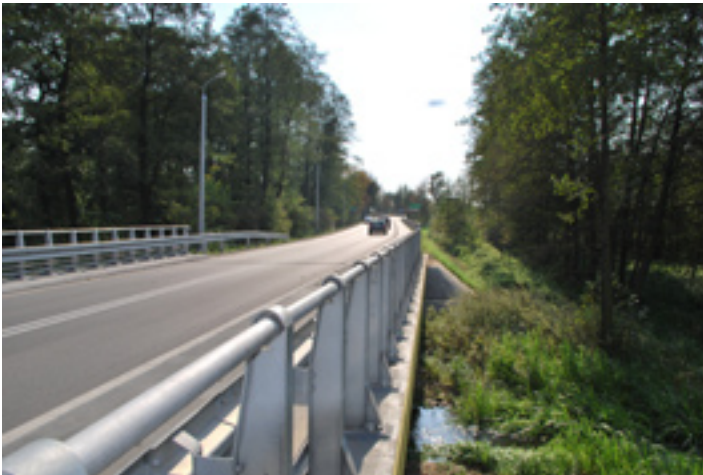
Przebudowany most na drodze Bełżyce – Strzeszkowice.
