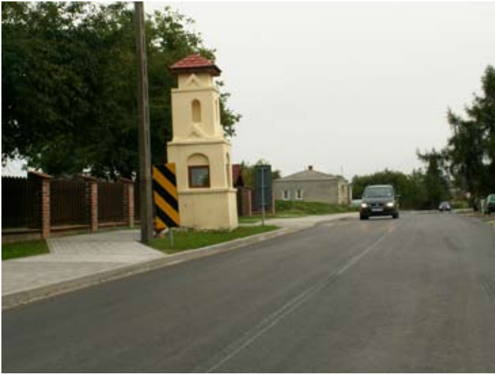
Na drodze Bełżyce – Strzeszkowice pozostały tylko prace wykończeniowe.
